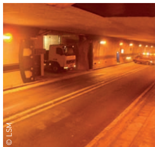
L'entrée du LSM dans le tunnel
